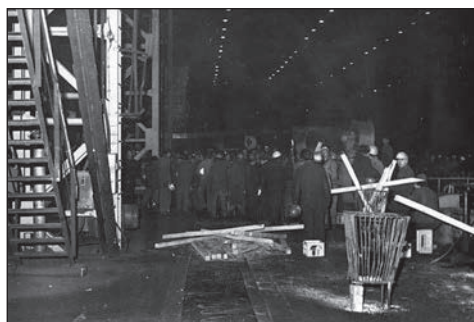
105. Oczekiwanie na atak na Walcowni Drobnej
