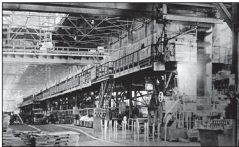
133. Ocynkownia ciągła blach
