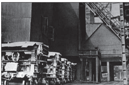
121. Transport surowki w kadziach na stalownię
