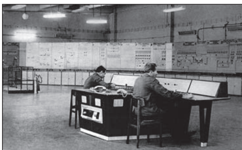
136. Dyspozytornia na jednym z wydziałów (Agglomerownia)
