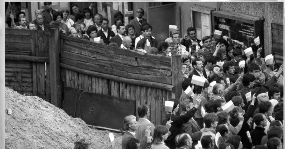
Msza św. w budowanym kościele na os. Kalinowym
